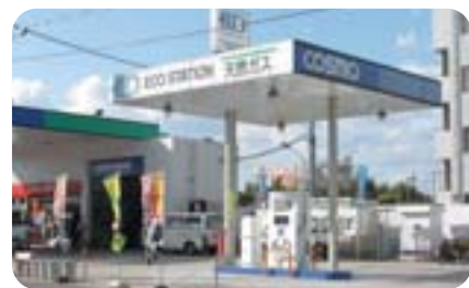
LNG Gas Filling Station
