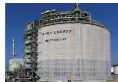
The No. 5 LNG tank at the Senboku LNG Terminal
