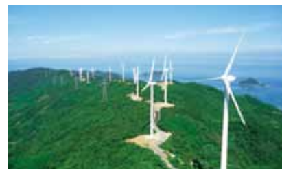
広川明神山風力発電所
