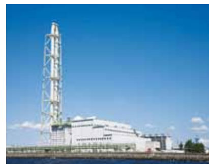
泉北天然ガス発電所
