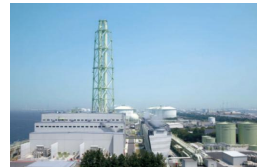
泉北天然ガス発電所
