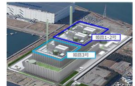
姫路天然ガス発電所
