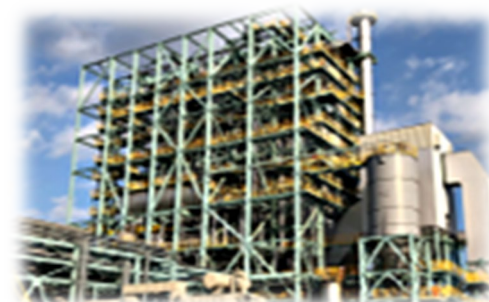
バイオマス発電所
